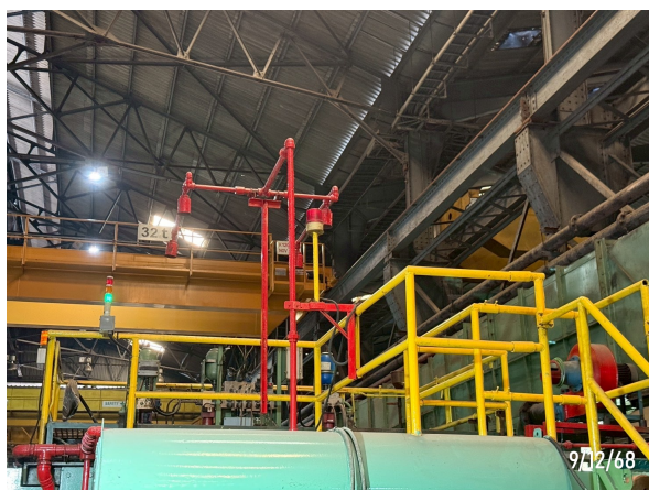
รูปที่ 2-9 ก๊าซคาร์บอนไดออกไซด์ดับเพลิงและป้ายเตือนการใช้ถังเก็บก๊าซคาร์บอนไดออกไซด์
